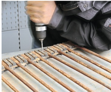
3 Die Nietköpfe ausbohren und schließlich den Nietrest ganz austreiben.
